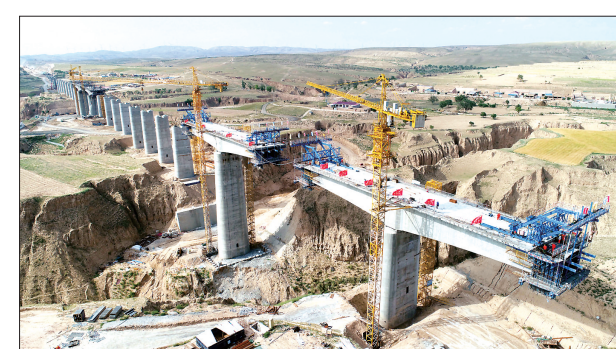
银西高铁甘宁段马坊沟特大桥施工现场(6月23日无人机拍摄)。目前,位于宁夏和甘肃交界的银川至西安高速铁路甘宁段建设正稳步推进。据了解,银西高铁是国家高速铁路网的重要组成部分,线路全长约617公里,设计时速250公里,计划于2020年底建成通车。 新华社发
