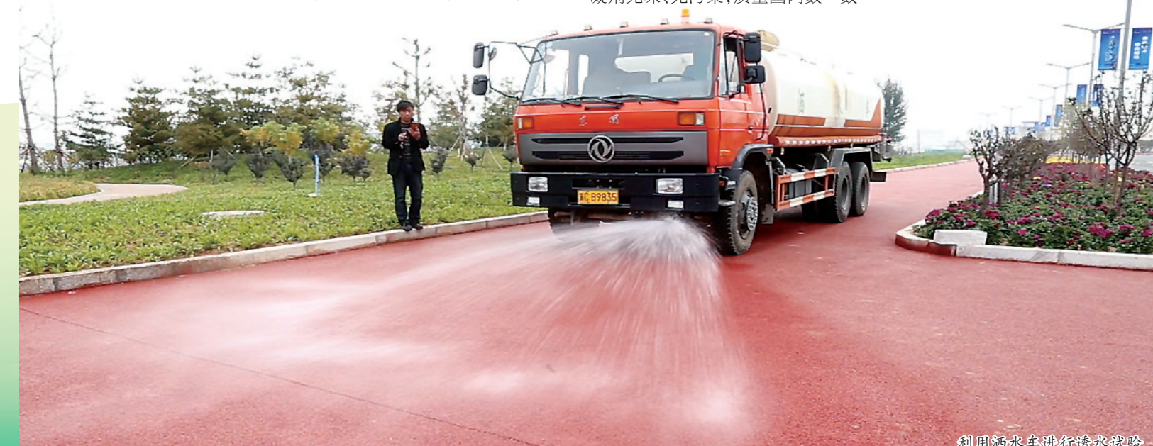
利用洒水车进行透水试验
