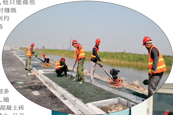
▲ 透水混凝土施工现场
