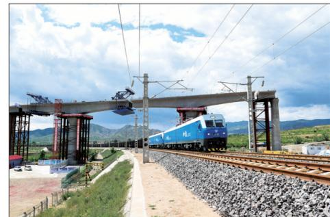
6月13日,经过304天艰苦奋战,由中铁二十局承建的2022年北京冬奥会重点配套工程——崇礼铁路全线最长桥隧川镇高架大桥上跨呼铁路现浇连续梁转体成功。据了解,全长53公里的崇礼铁路作为北京2022年冬奥会滑雪赛场主干道,全线建成后,将与新建京张高铁主线一起形成北京至崇礼区太子城奥运村最便捷的客运通道。
