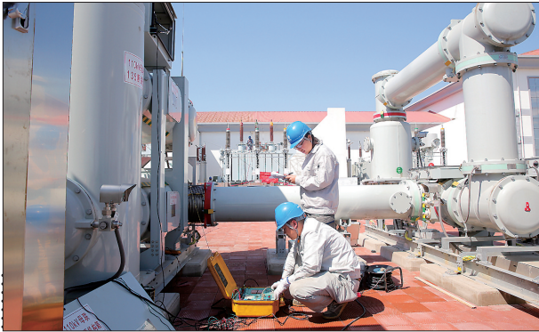
日前,秦皇岛电力部门已完成辖区内绝大部分变电站、输电线路检修和预试,及时消除设备隐患,为确保迎峰度夏安全供电奠定坚实基础。图为电力员工在110千伏海滨变电站进行预试。 史文全 摄
