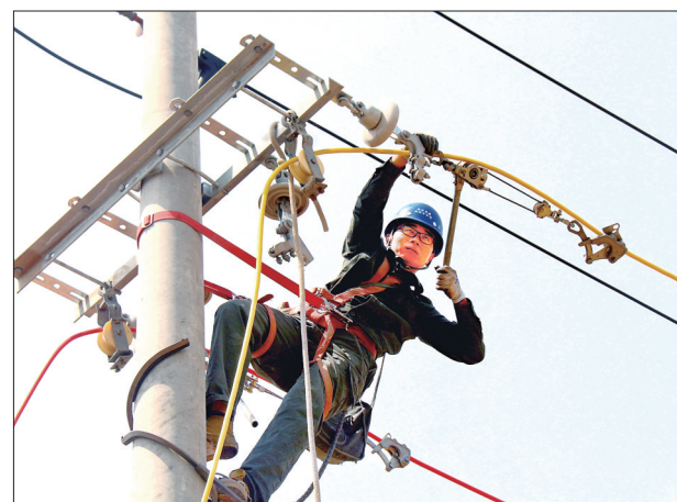
近日,国网故城县供电公司员工在“美丽乡村”电网改造升级项目建设中架设供电线路。
