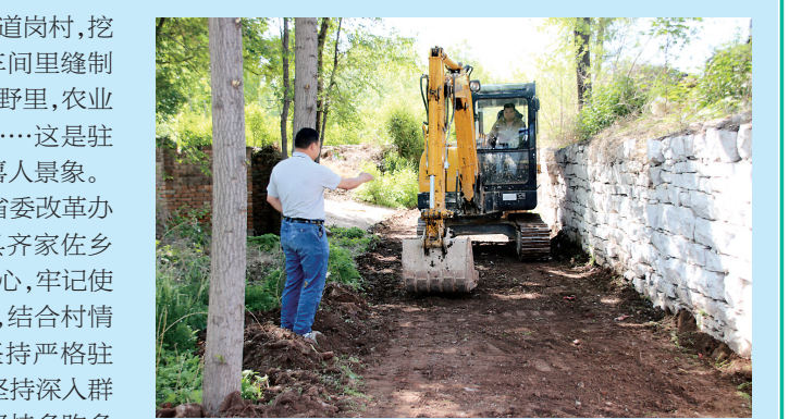
利用挖掘机平整村路。
