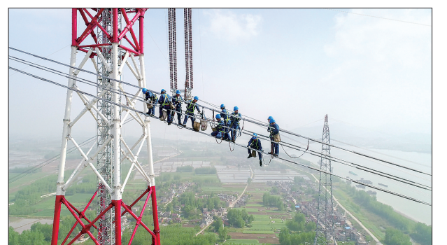
4月15日,在安徽省无为县高沟镇,工人们在昌吉特高压长江大跨越工程跨越塔架上进行高空作业(无人相机拍摄)。当日上午九时许,位于无为县高沟镇的±1100千伏吉泉长江大跨越塔架北岸张力场正在紧张施工。随着西电东送±1100千伏“新疆准东—安徽皖南”特高压直流工程的最后一相导线顺利跨越天堑长江,世界电压等级最高的特高压大跨越——昌吉特高压长江大跨越工程全线贯通。新华社记者 郭晨 摄
