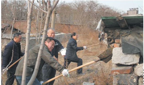
近日,冀中能源邯矿集团康城煤矿党委组织拆除井口周边违章建筑,平整场地,植树造林,绿化环境,建设绿色矿山。图为矿领导带领党员拆除违章建筑奉献劳动场景。
